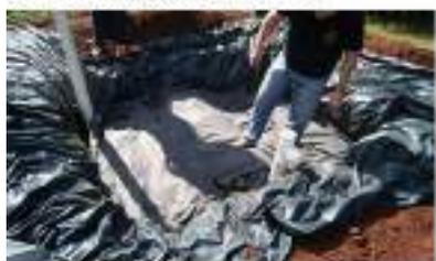
Figura C – Instalação da manta geotêxtil;
