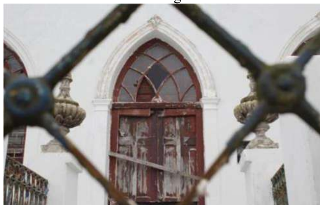
Imagem 7 - Exemplo de arco em ogiva perfeita presente em edificação do Centro Histórico de Paranaguá
