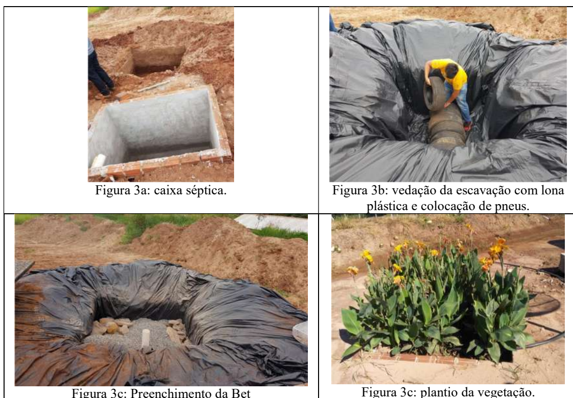
Figura 3- Construção da BET_2 em Araruna.
