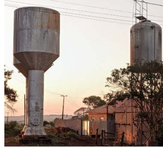
Imagem 2: Rede de captação de poço artesiano
